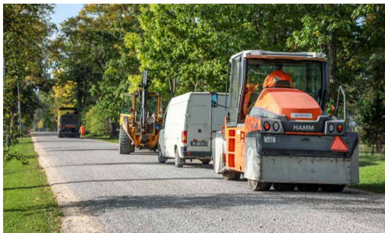
Investīcijas pagastos – Mētrienā Centra ielā veikta dubultā virsmas apstrāde.
