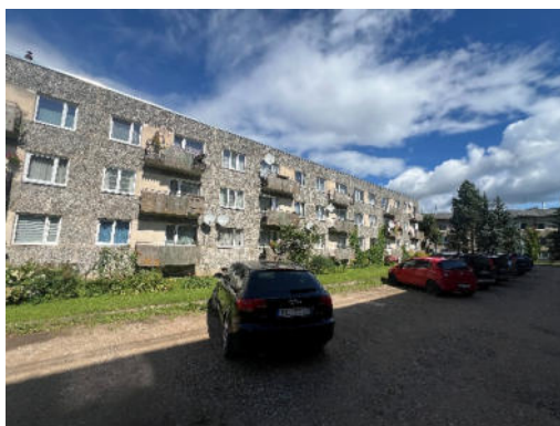
1.attēls. Dzīvojamās mājas fasāde
