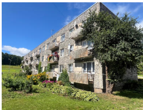
2.attēls. Dzīvojamās mājas fasāde
