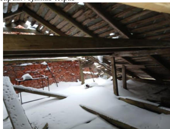
15., 16.attēls. Ēkas bēniņi (jumta bojājumi)
