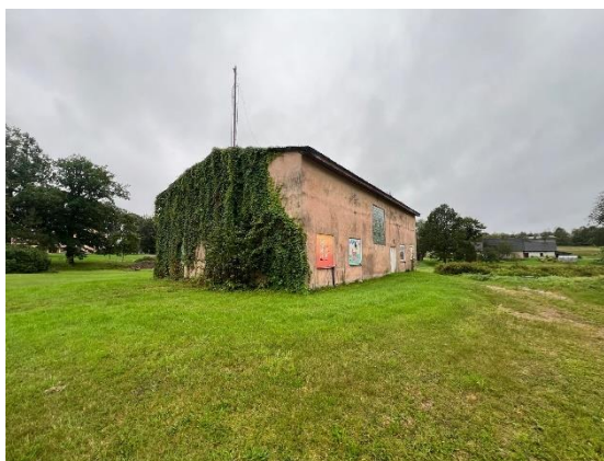
2.attēls. Dispečeru ēka
