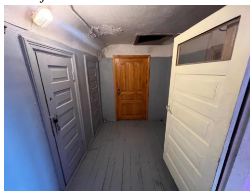
4.attēls. Kāpņu telpa
