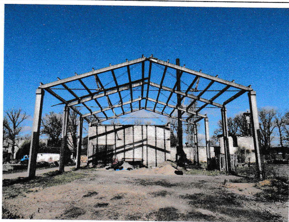
(Attēls nr. 7 un 8 – karkasa elementi: kolonnas, kopnes un rīģeļi)
