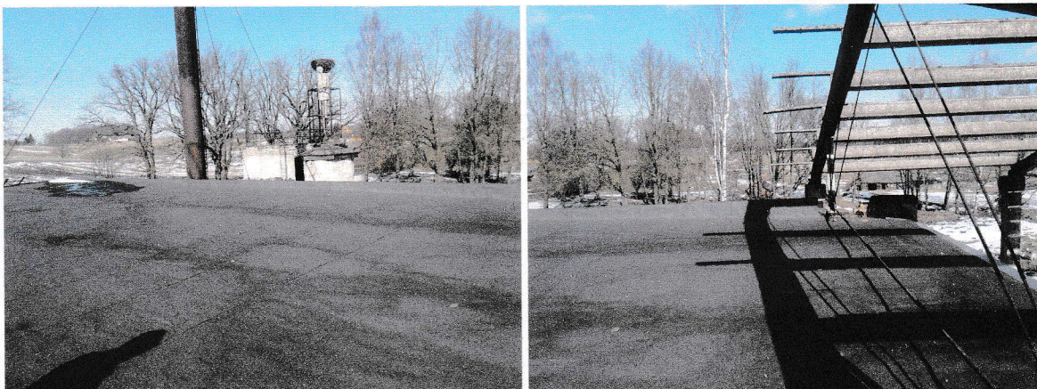
(Attēls nr. 11 un 12 – saimnieciskā kārtā pārlīmēts esošais "līmētais" jumts)
