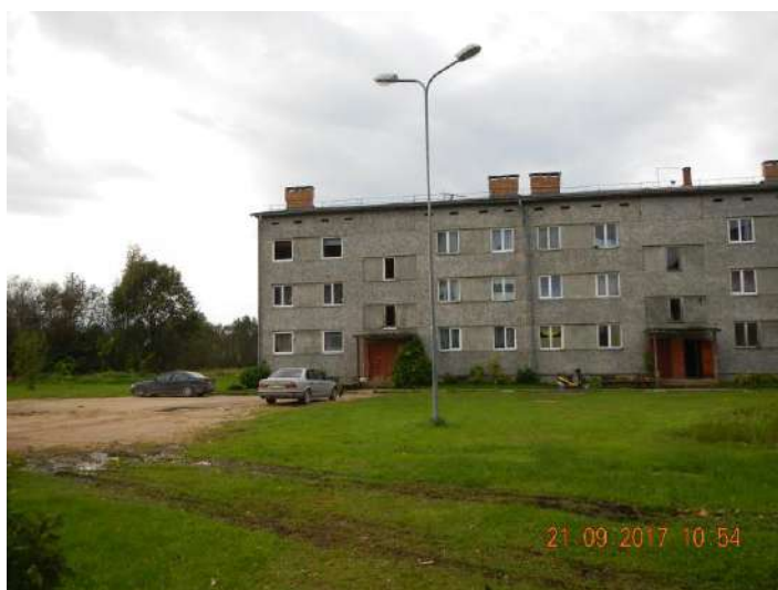
8. att. Esošais ielu apgaismojuma stabs daudzdzīvokļu māju pagalmā
