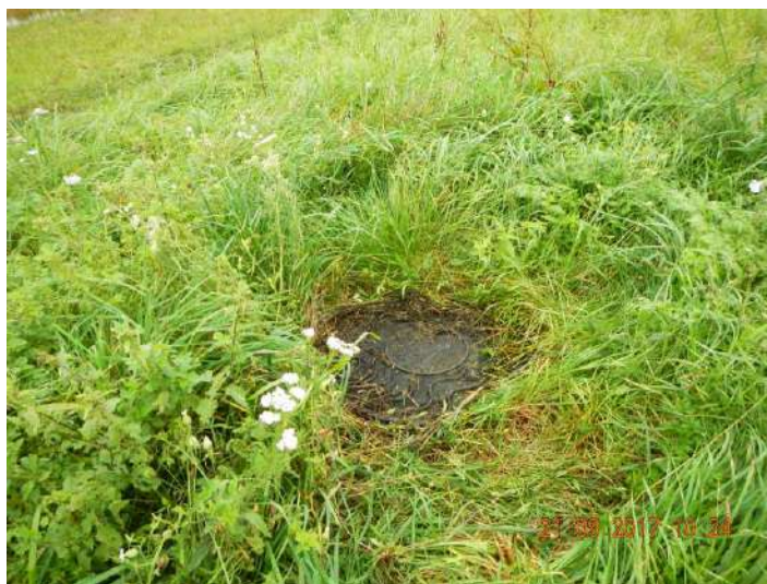
6. att. Demontējamā sadzīves kanalizācijas aka
