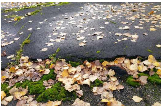
5., 6., 7. att. Esošais asfaltbetona segums Futbola laukumā un uz skrejceļa izveidojušās peļķes (skat. 8.att.)
